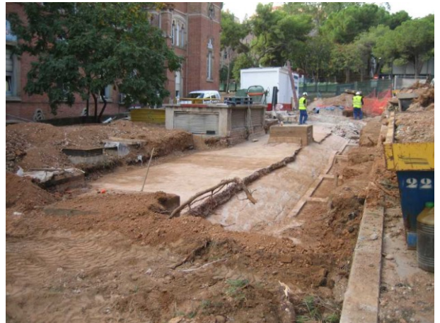
Fotografia 06. Vista general de la volta, claraboies i contraforts
