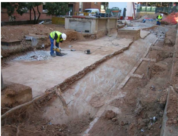
Fotografia 07. Vista general de la volta, claraboies i contraforts
