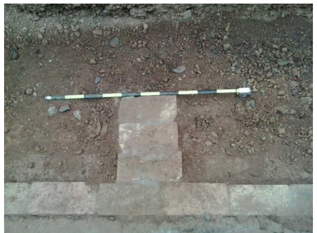
Fotografia 08. Detall d'un dels contraforts afectats
