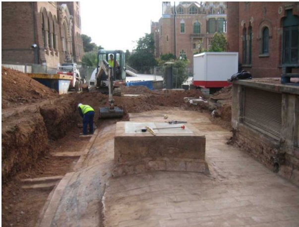
Fotografia 05. Vista general de la volta, claraboies i contraforts
